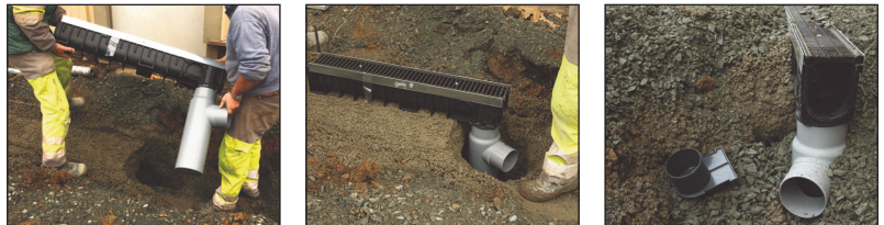
Setting an Ekso sump unit
